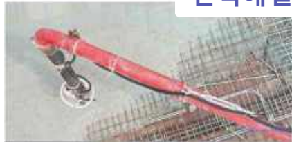
콘크리트 시공로봇으로 시공인부 절감
