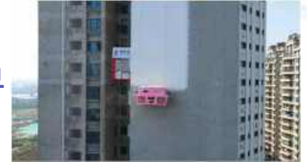
전통적인 인력 곤돌라 작업 대신 외벽 페인트 로봇 시공
